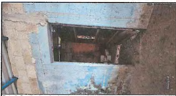
Foto 5: Sustitución de piso de torta de concreto por piso cerámico, sustitución de puerta de metal, Cernido de muros interiores, Pintura en muros interiores.
