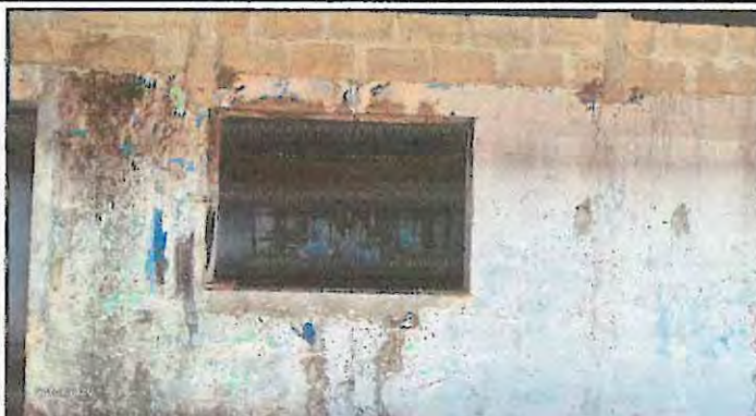
Foto 2: Cernido de muro interior, Pintura en muros interiores y exteriores, implementación de ventana.
