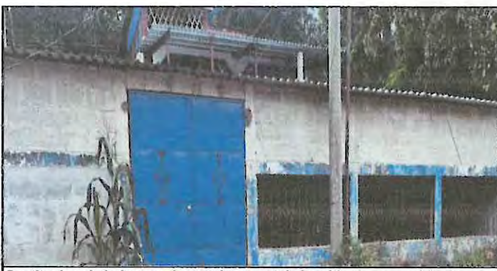
Sustitucion de balcones de metal por metal, Cernido de muros interiores y exteriores, Implementacion de canales de metal exterior, Pintura en muros interiores y exteriores.
