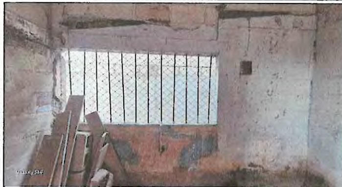
Foto 1: Cernido de muro interior, Sustitución de balcones de metal, Pintura en muros interiores y exteriores,
