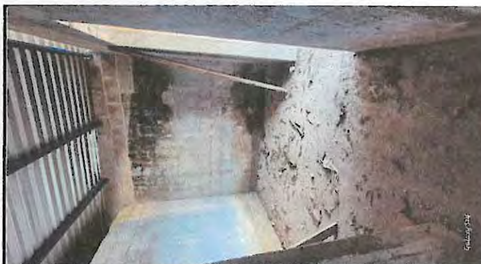
Foto 4: Sustitución de piso de torta de concreto por piso cerámico antideslizante, Cernido de muros interiores y exteriores, Implementación de puertas de metal, Pintura en muros interiores, Implementación de
